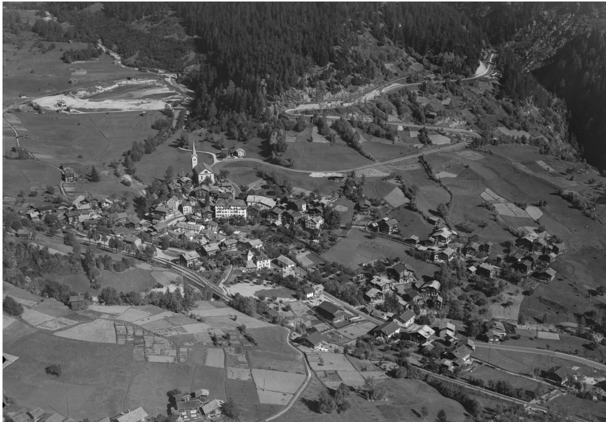
Fiesch, Luftaufnahme 1973 – im Hintergrund links oben die Lischmatte – der Bauplatz des neuen Alters- und Pflegeheims
